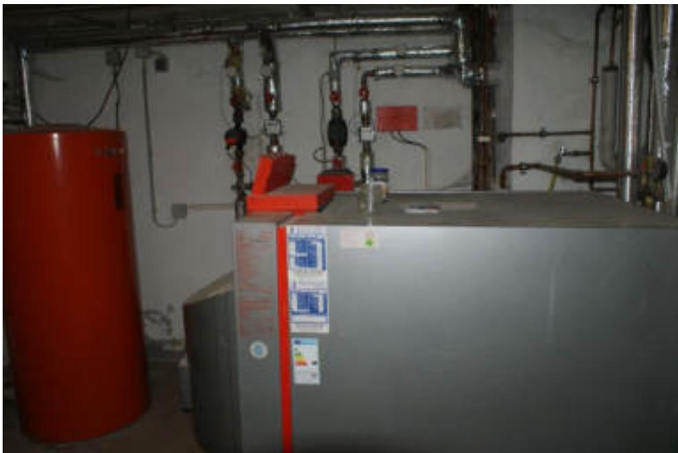
Bild 66 Ölheizung mit Prüfplaketten / links Warmwasserspeicher
