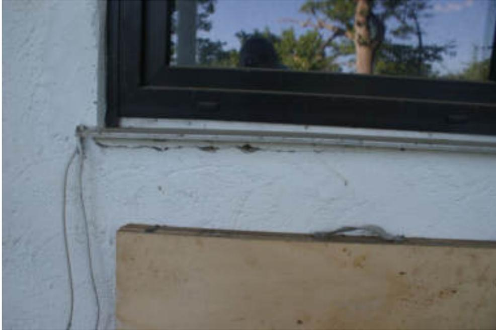
Bild 129 Beispiel Putzrisse außen an einem Fenster
