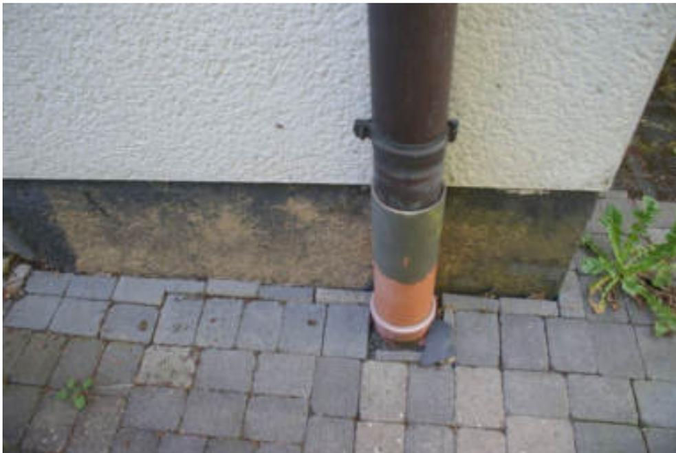
Bild 123 Weitere Nässeschäden am Sockel und der Entwässerung
