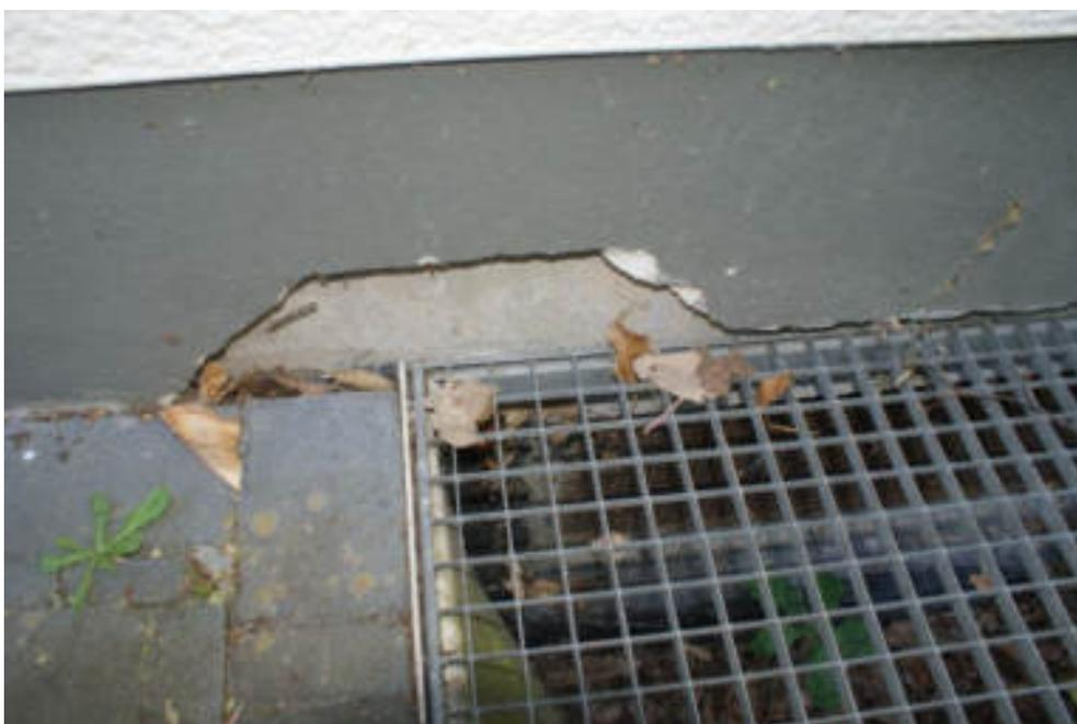
Bild 124 Beispiel Putzausbruch am Lichtschacht
