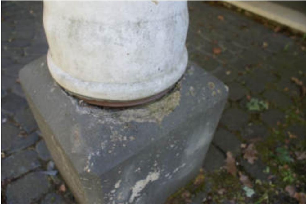
Bild 125 Nässeschaden am Pfeiler Eingangsüberbau
