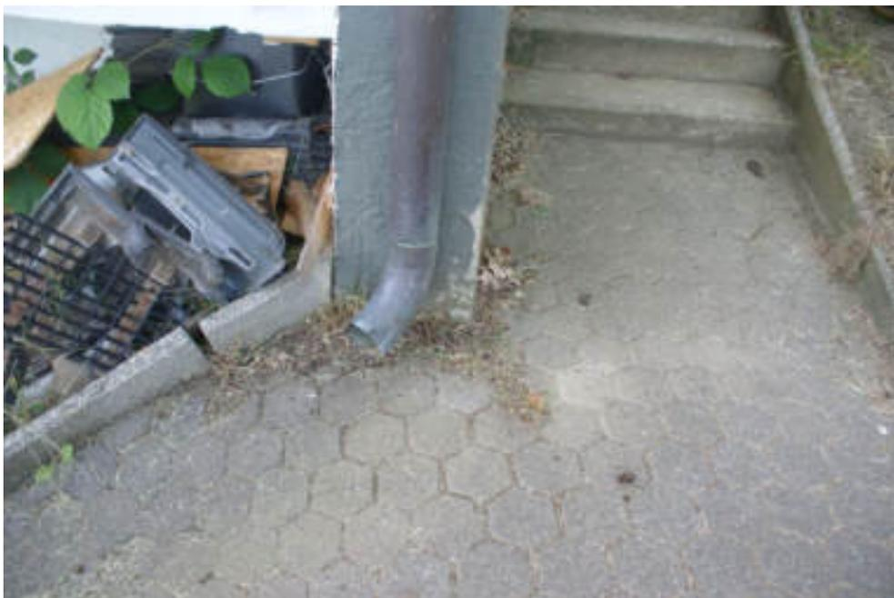
Bild 128 Unkontrollierter Regenwasserabfluss
