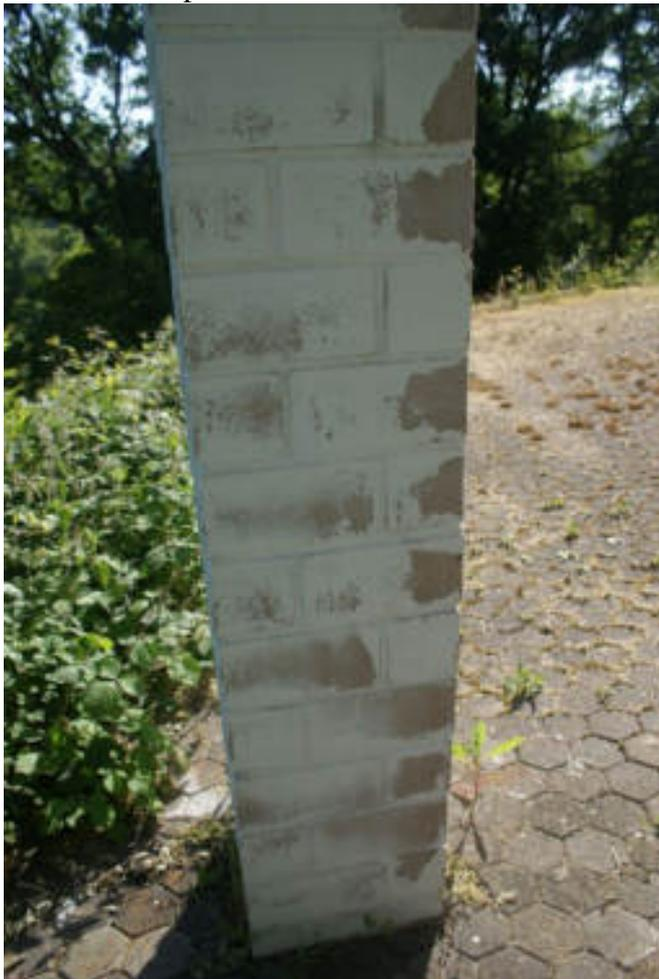
Bild 130 Nässeschäden am Pfeiler KG
