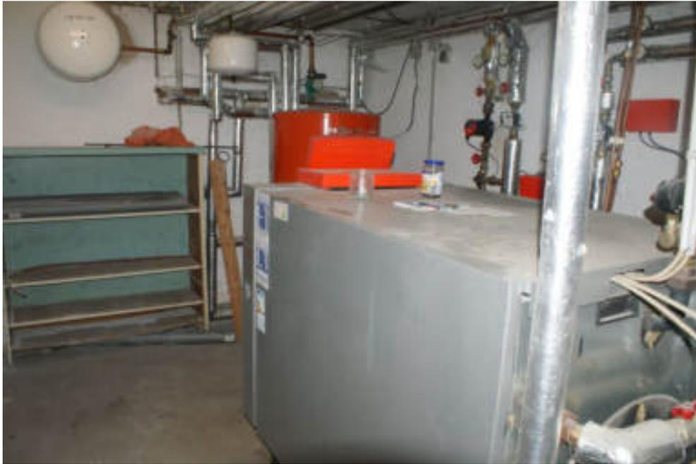
Bild 65 Ölzentralheizung im KG für Gesamtobjekt
