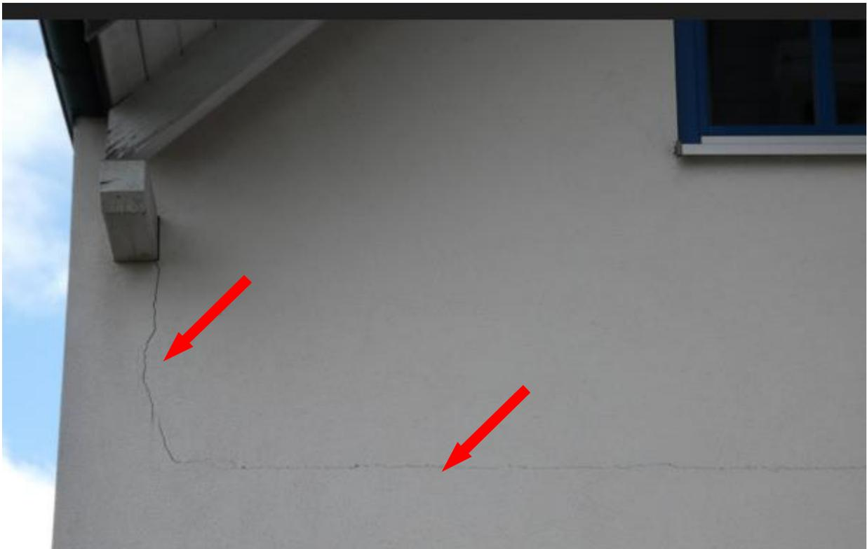
**Detail: Mauerriss im Übergangsbereich Mauerwerk ó Dachkonstruktion (vgl. Pfeile) auf Seite Nord des Wohnhauses, Gebäudeeck Nord-/Ost.**
